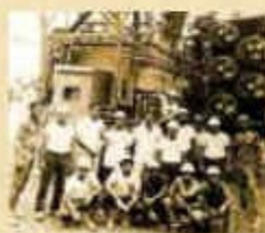
Fotografía histórica en la que se aprecian trabajadores eléctricos posando frente a enorme transformador de la época.
